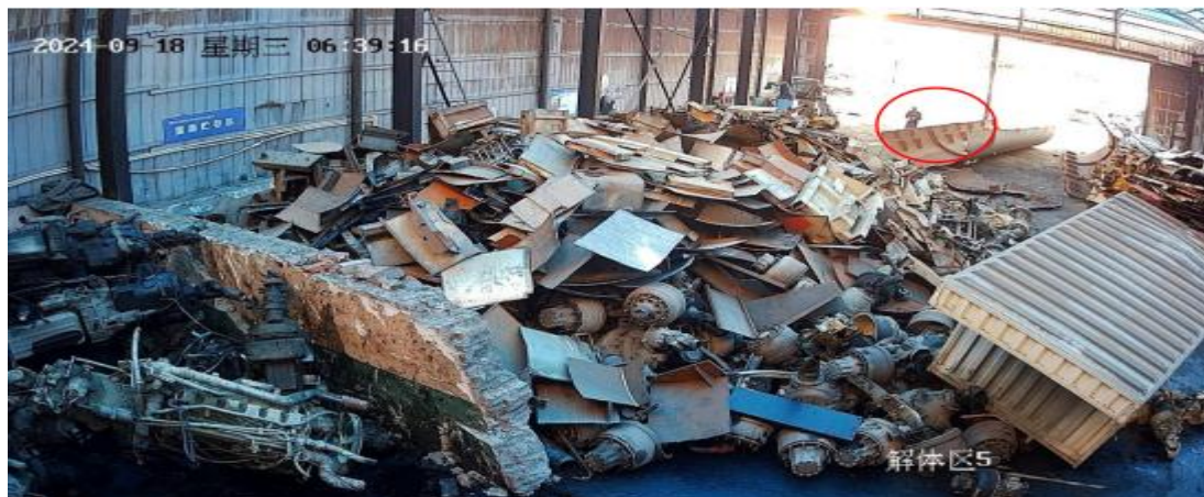
图-1 向正波到达车间现场开始清理现场杂物作业
