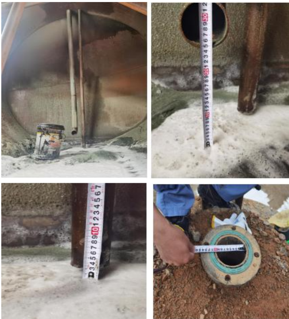
图 12 储罐内部尺寸情况
